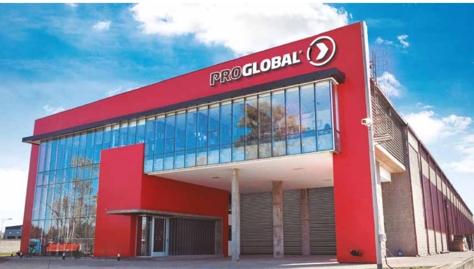
Argentina, Oficinas Centrales
