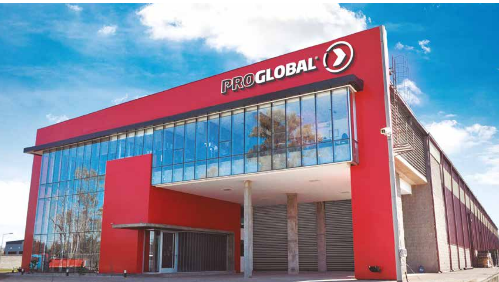
Argentina , Oficinas Centrales
