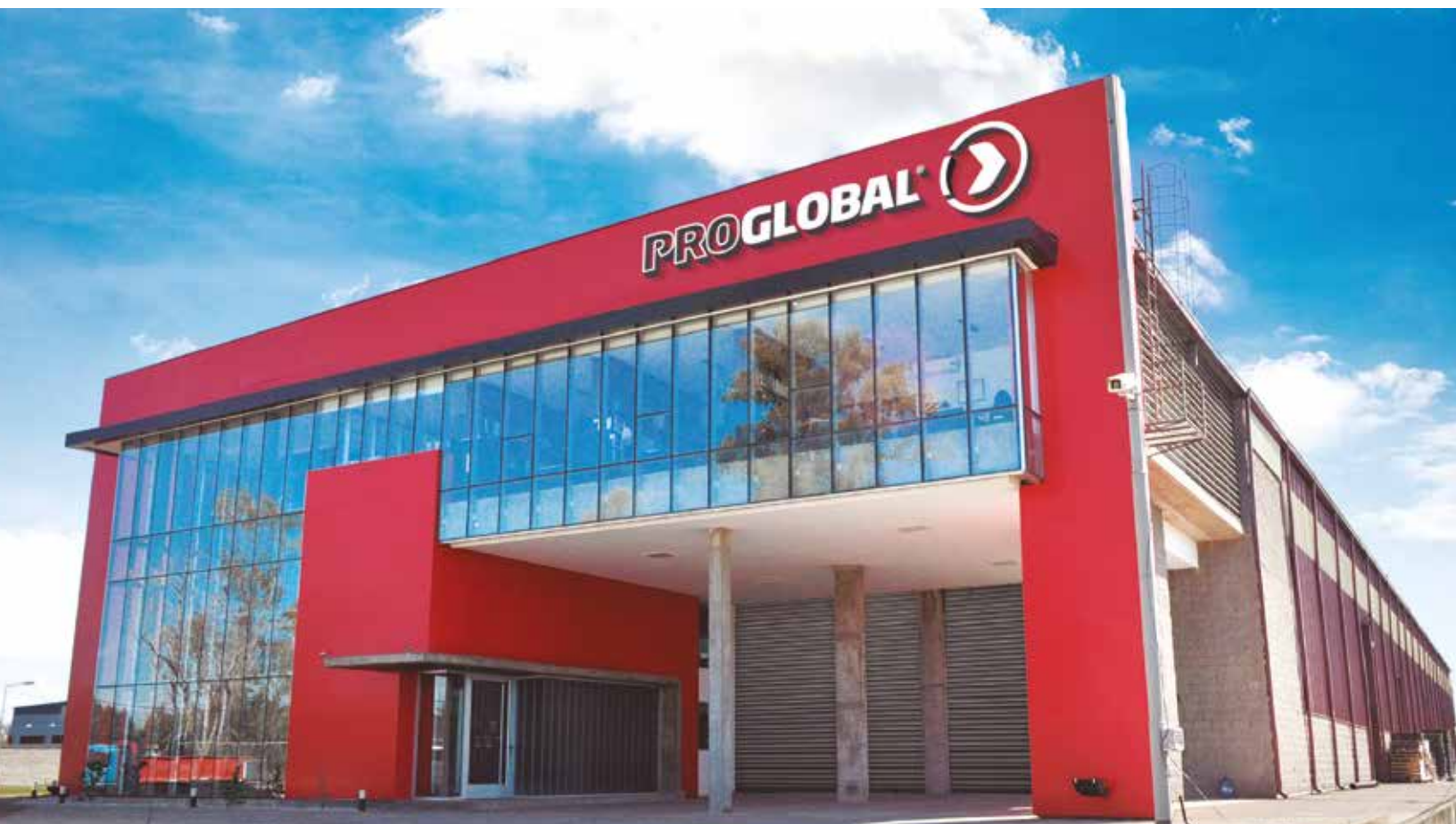
Argentina , Oficinas Centrales
