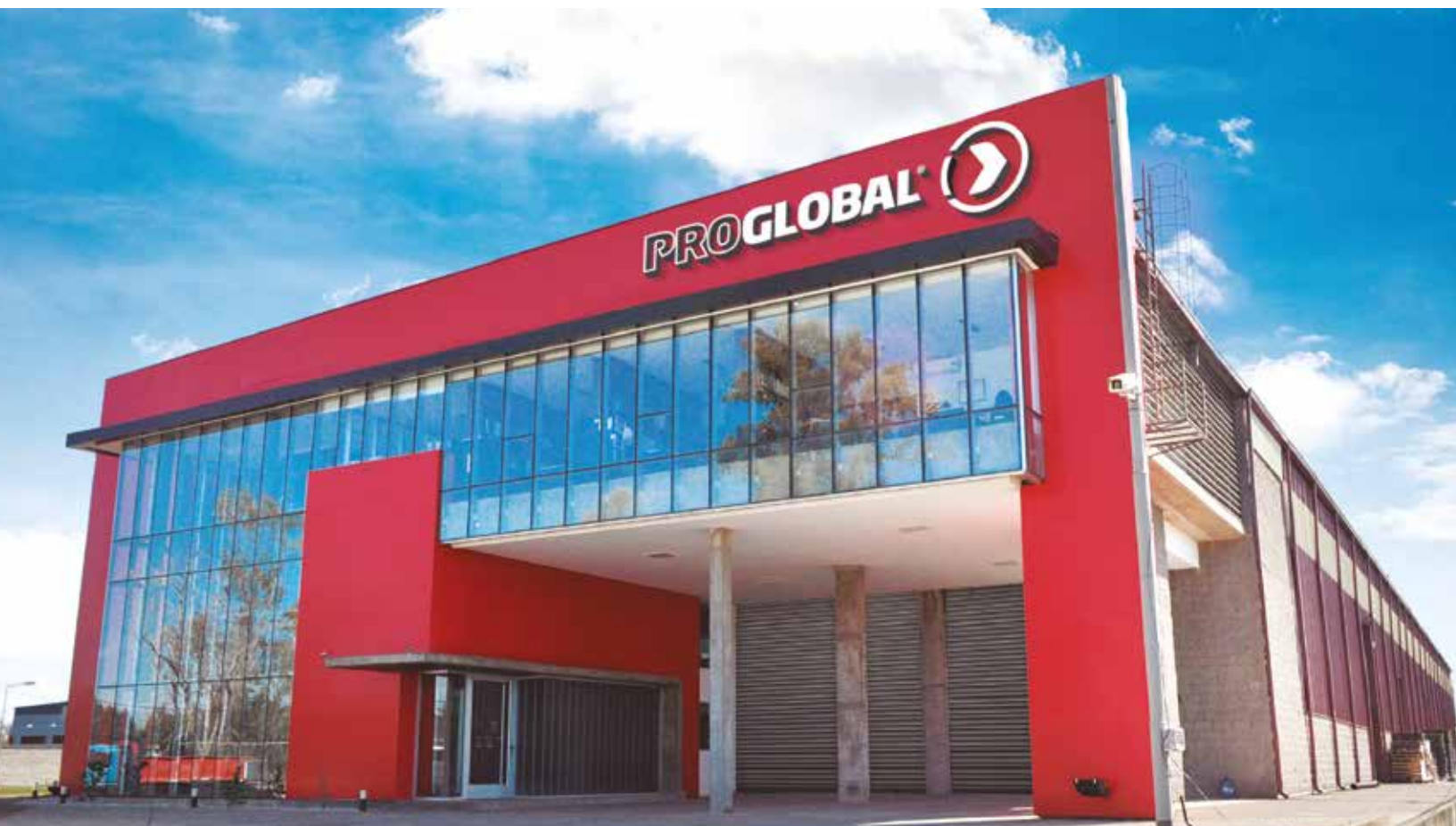
Argentina , Oficinas Centrales
