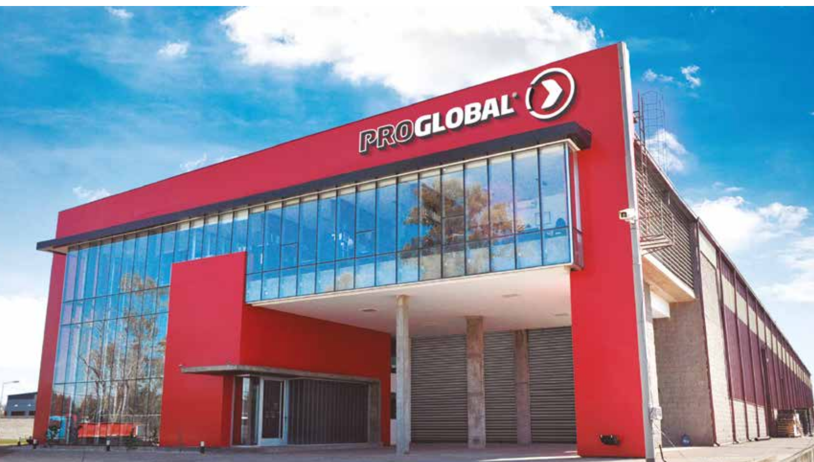
Argentina , Oficinas Centrales
